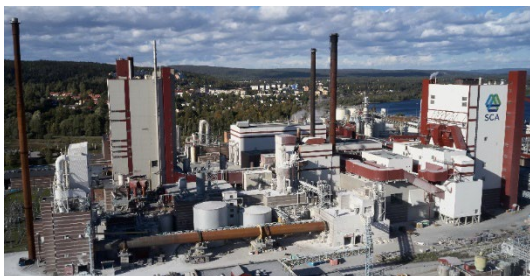
Drehrohrofen und Rückgewinnungskessel in der SCA-Fabrik Östrand (Bildnachweis: Behrendt und Rausch)
